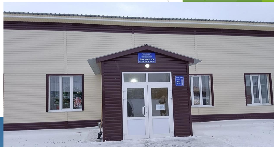
Фасад здания после ремонта
