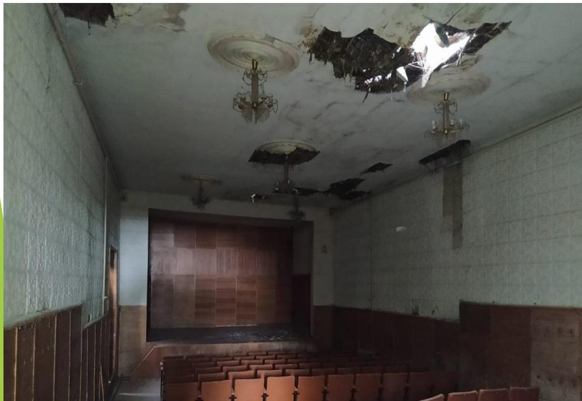
Зрительный зал до ремонта
